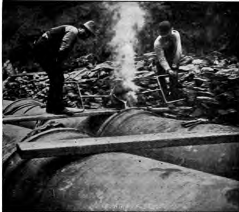
FIG. 22.—POURING A JOINT.
