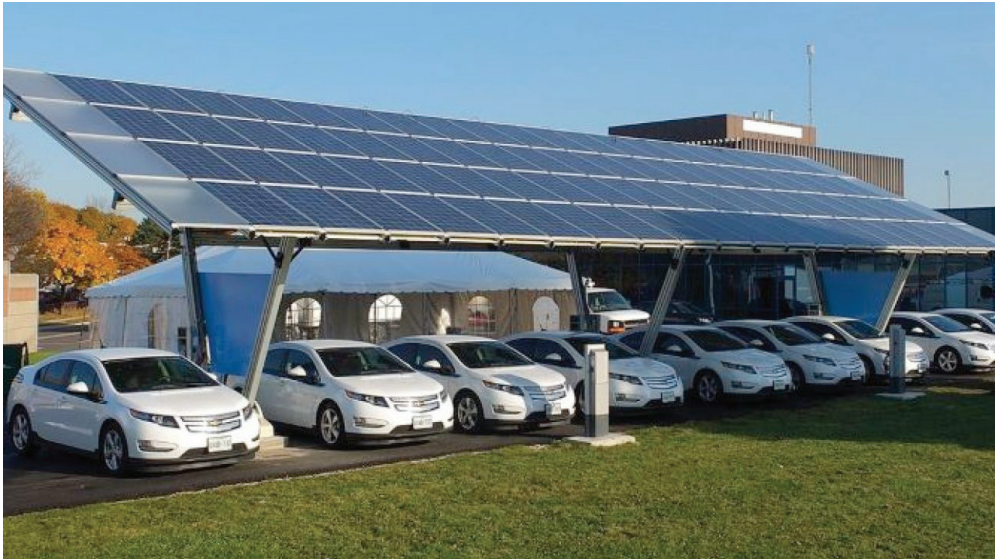
شكل (9) مظلة موقف سيارات تحتوى على خلايا شمسية ومحطة شحن تعمل بالطاقة الشمسية
