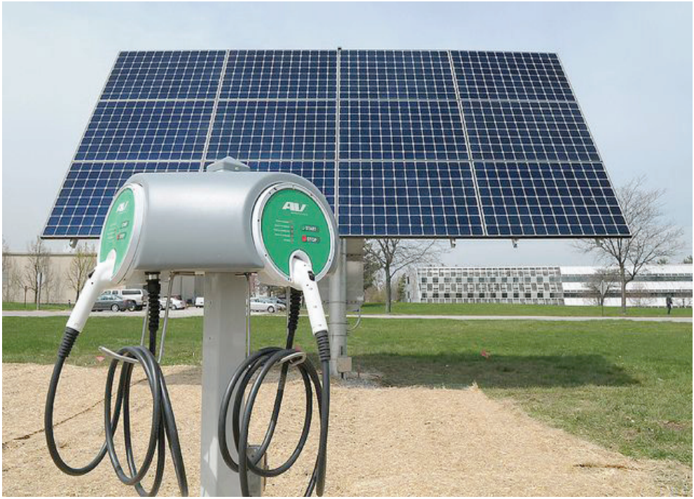
شكل (8) محطة شحن تعمل بالطاقة الشمسية
